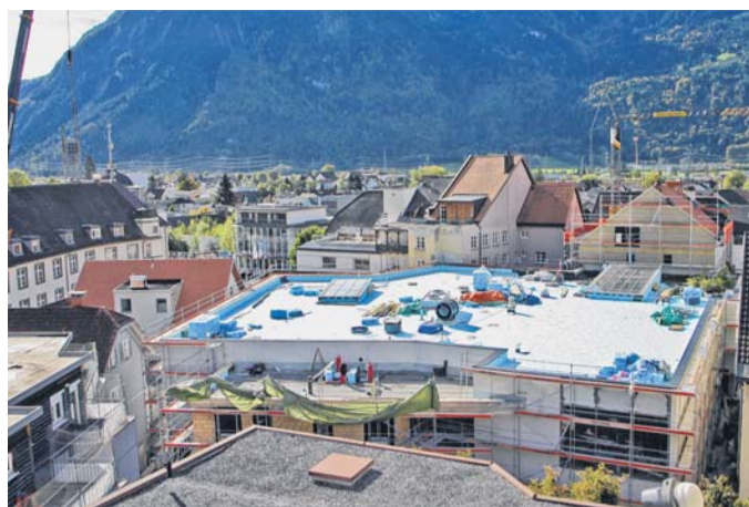
Wird am 22. November seine Pforten öffnen: das Altstadt-Einkaufszentrum Kronenhaus in Bludenz. FOTO: SCHWALD
